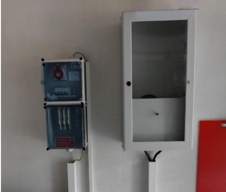
Bild 1: Revisions-Hausanschluss 302 x 604 x 180 mm (BxHxT)
