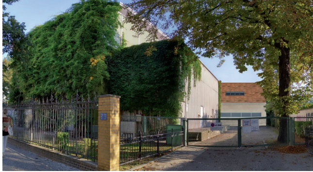
التوسعة المخطط لها ومبنى محطة تحويل الطاقة الكهربائية الحالي (صورة من شارع Richardstraße)
