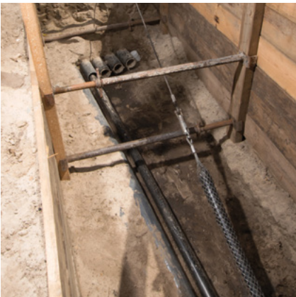
Kabelschacht bei Baumaßnahmen für 110 Kilovolt
