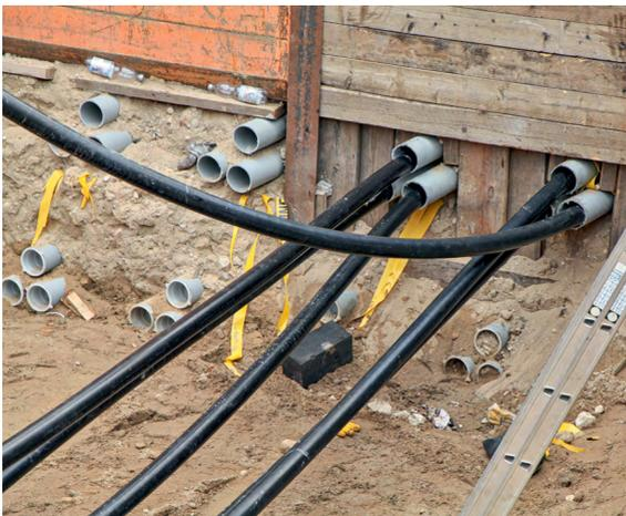
Stromkabel liegen in Berlin zu 99 Prozent unter der Erde. Über Netzknoten (rechts oben) wird die elektrische Energie in Umspannwerke verteilt.
