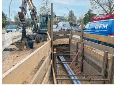
**Offene Bauweise:** Kabelgraben für Mittelspannungskabel
