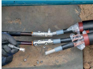
Muffenverbindungen von Mittelspannungskabeln
