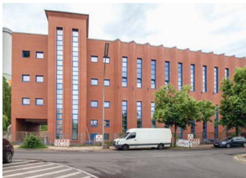
Der neue Hochspannungsnetz-knoten in Berlin-Charlottenburg
