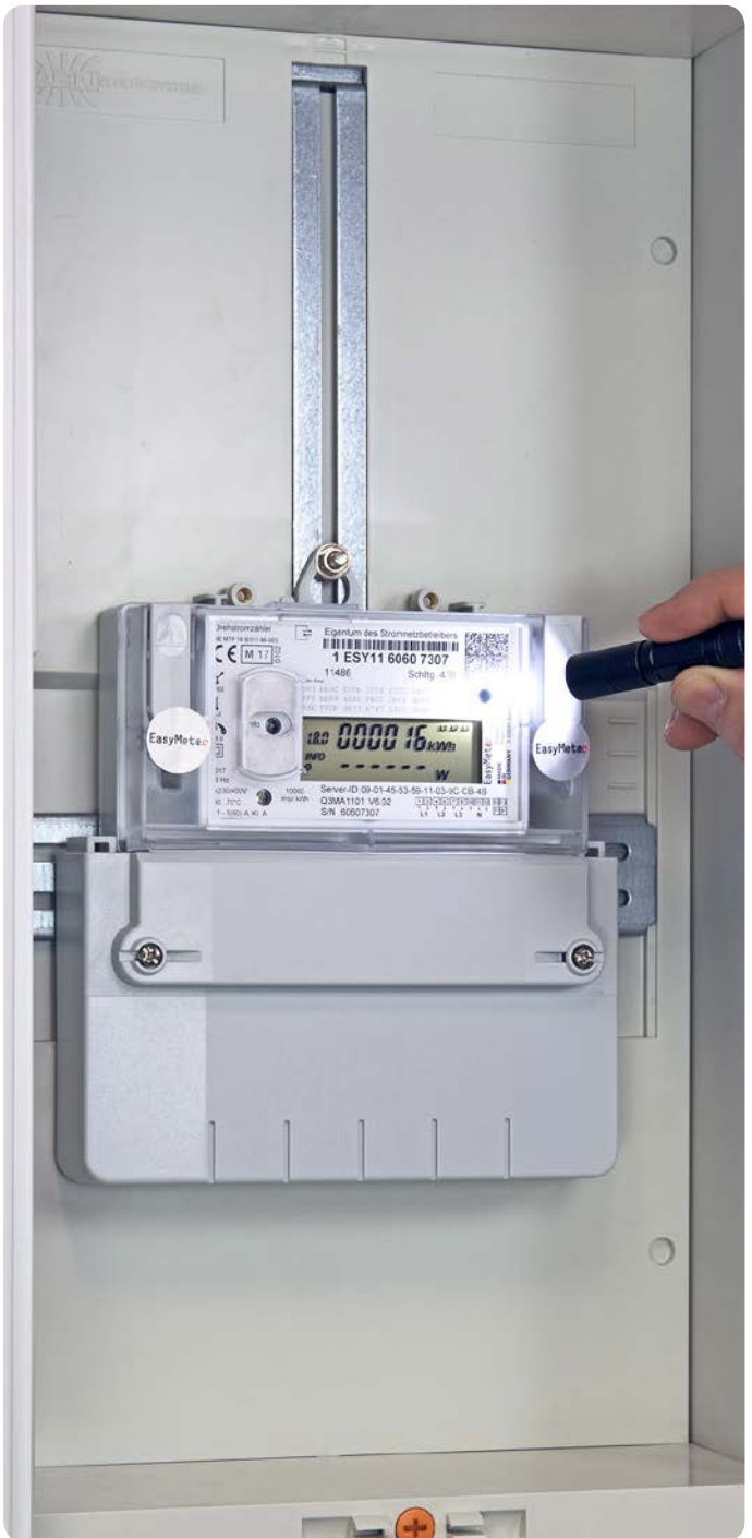
Moderne Messeinrichtung, Hersteller: Easymeter
